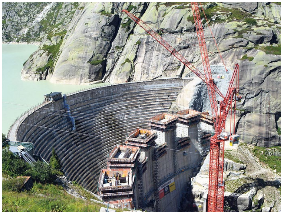
Die imposante Grossbaustelle auf dem Grimsel.
